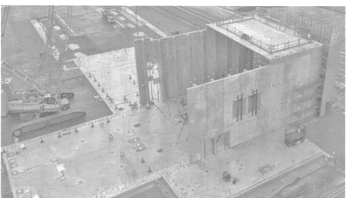
建込が始まった福島RDMセンター
