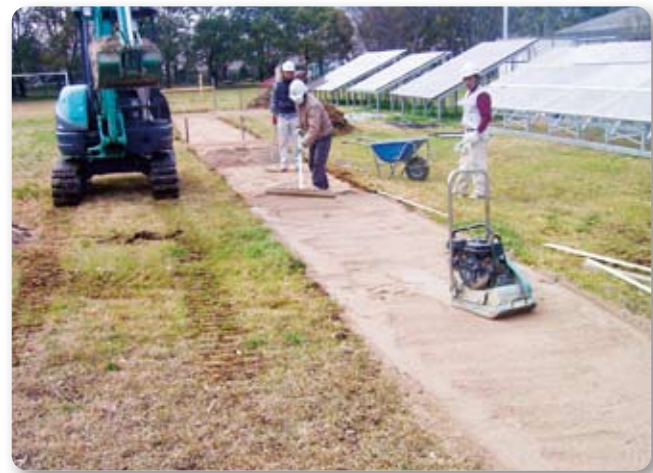
1 基礎モルタル
