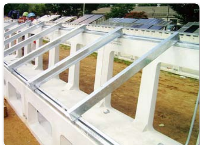
5 モジュール金物取付
