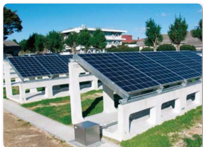
6 モジュール取付
