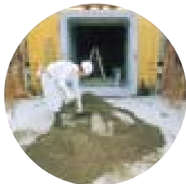
2 敷モルタル工
