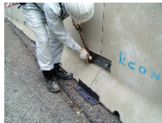
連結プレート取付け状況
