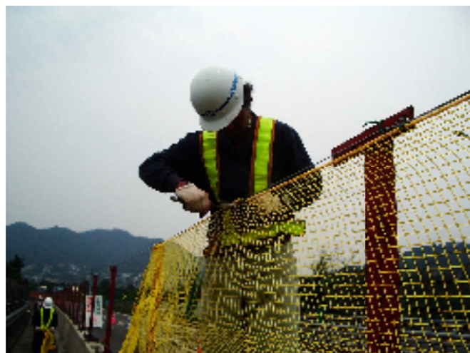
目隠しネット取付け状況
