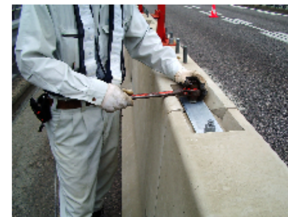
連結プレート取付け状況
