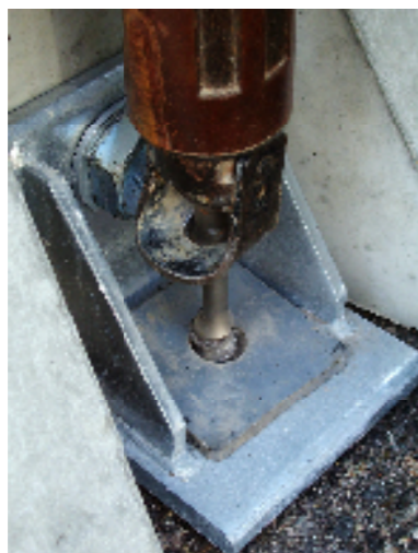
ズレ止めアンカーの設置
