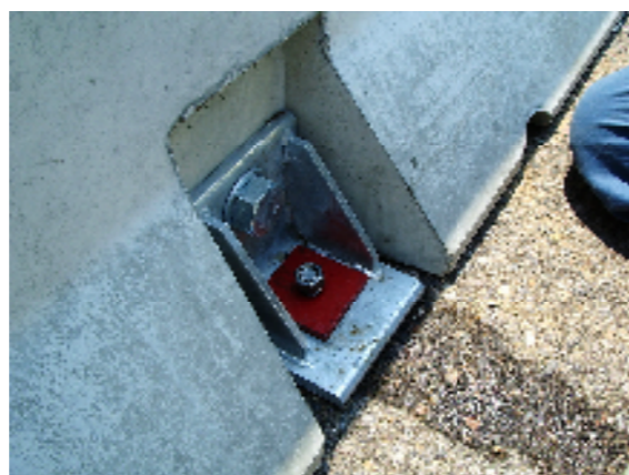
ズレ止めアンカーの設置
