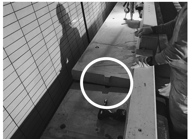
写真-2 切欠けによる設置誘導
