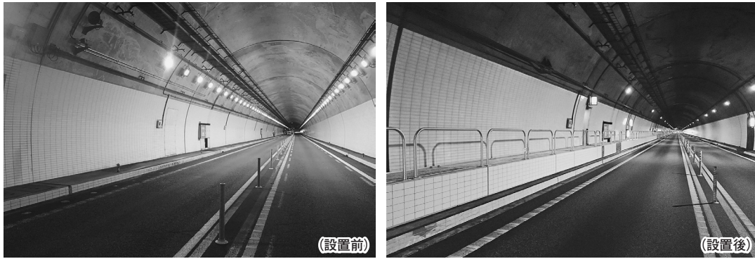
写真-3 監視員通路設置状況
