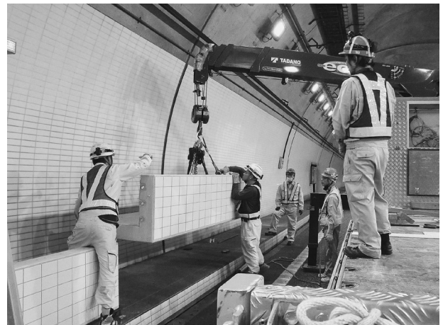
写真-1 プレキャストL型擁壁設置工法
